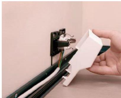
Gerätetank in das SL-Unterteil einhängen.
