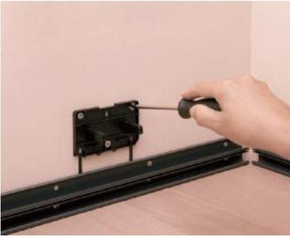
Bei der Kanalhöhe 50 mm den Geräteträger so am montierten Sockelleistenunterteil ansetzen, dass die beiden Stege als Abstandshalter aufliegen. Anschließend bohren und an der Wand verschrauben (Bild ohne montierten Steckdosensockel).
